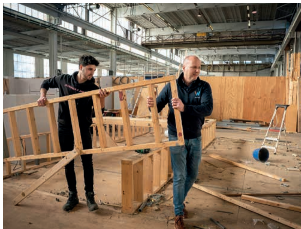
Michael Groot Nuelend (voorop) en Tigo Roelofs bezig met het demonteren van het circulaire huis. foto: Erik van 't Hullenaar
